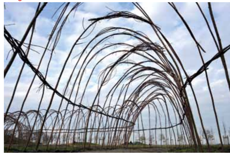
Een tunnel van gevochtene wilgentenen slingert door Tobias' Tún. De vorm is alvast met oud materiaal geplaat door mandenmakerij De Mythe uit Zuidschermmer. Komend voorjaar worden verse groene slieten aangeplant, die gaan uitlopen tot de bedoelde groene tunnel.
