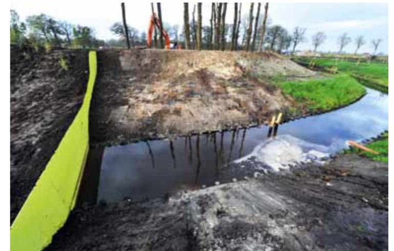
Een geel geverfde stalen wand van 5,5 m hoogte, die deels in de grond zit, zorgt voor steun in Tobias' Tún. Rehberger heeft bewust uitgesproken kleuren gebruikt om spankelingen in het park te bewerkstelligen.
