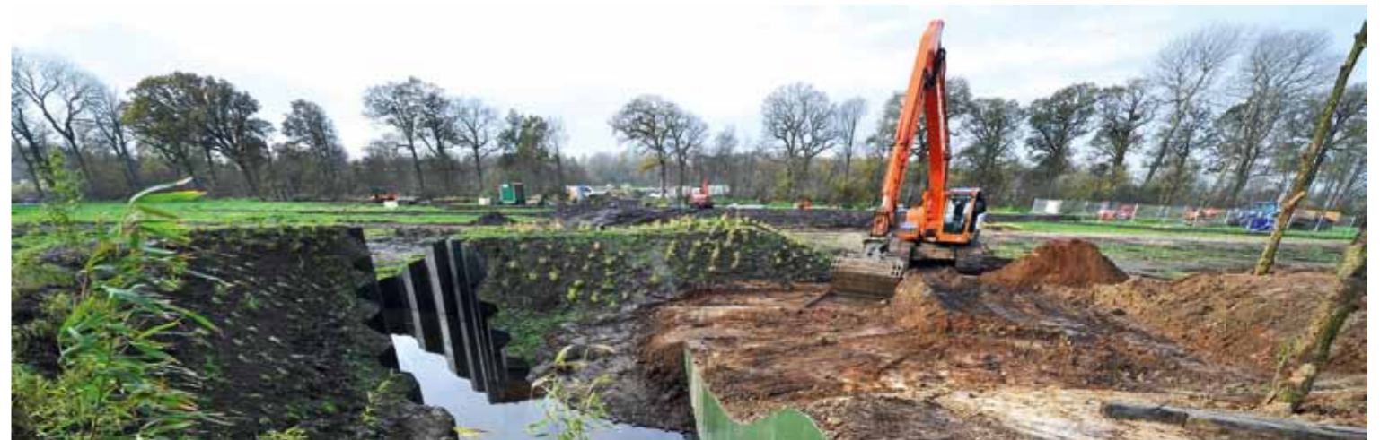
Een ravijn in Tobias' Tún is gemaakt van damwandplanken en metalen wanden in groen en geel. Het plantwerk is van verschillende soorten bamboe, waarvan sommige soorten wel zes meter hoog kunnen worden. Dit zorgt voor een groene verticale accentuering ten opzichte van het 'ravijn'.
