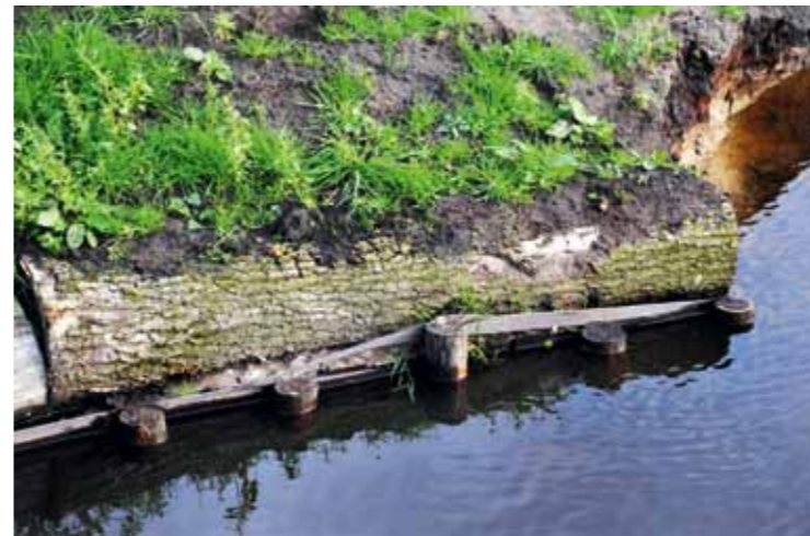
Boomstammen uit het bestaande park Vijversburg worden langs de slootkanten in Tobias' Tún hergebruikt. Tijdens een van de herfststormen in 2013 sneuvelde een aantal.
